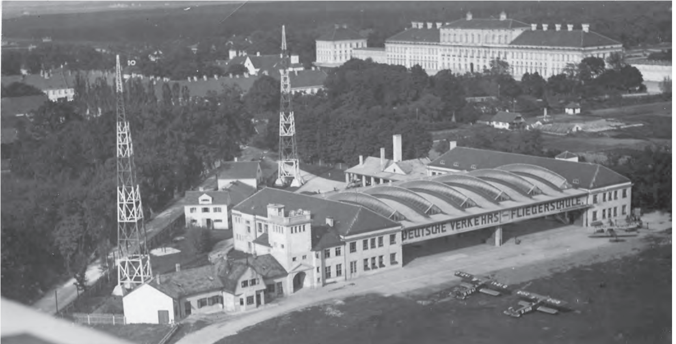
Die 47,5 Meter hohen Antennenmasten der Flugsicherung prägen das Bild des Flugplatzes
