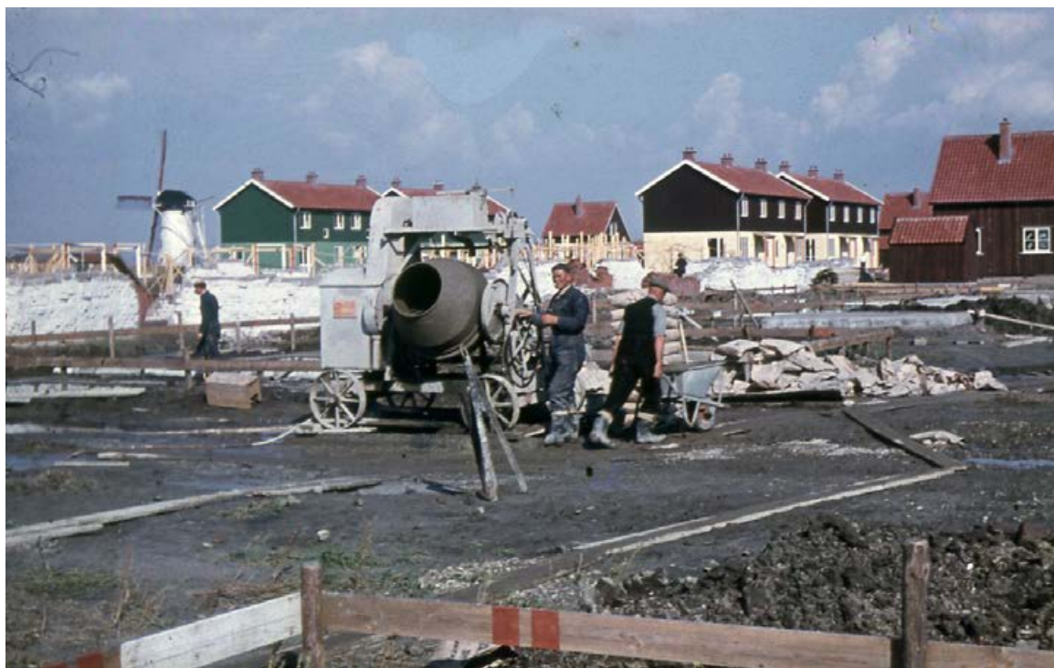
Woningen in aanbouw in Nieuwerkerk, Schouwen-Duiveland
